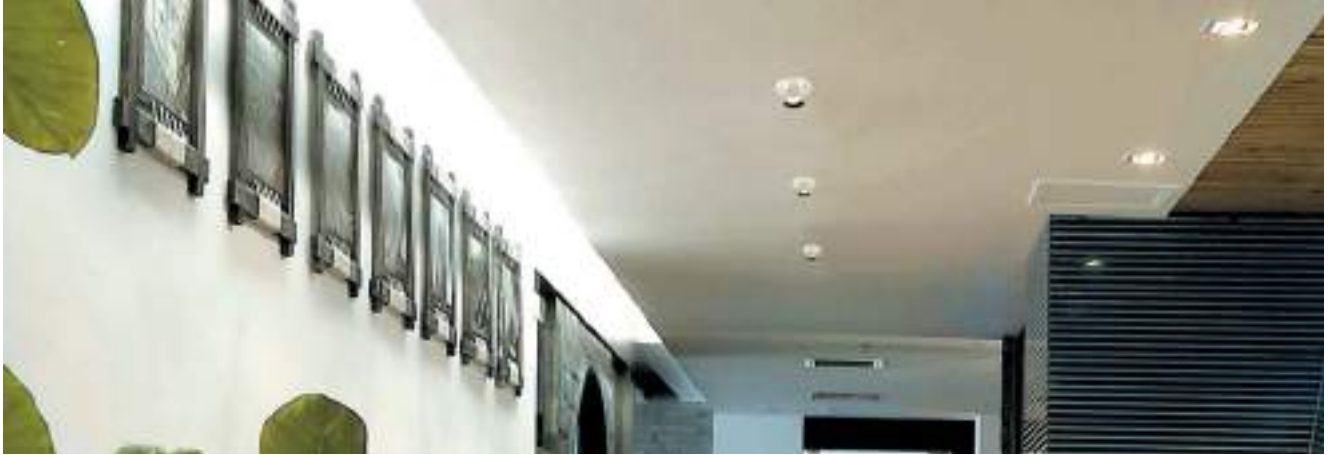
RECESS DOWNLIGHT LED (ADJUSTABLE) / โคมไฟดาวนไลท์แอลอีดีฝังฝ้า ชนิดปรับมุมได้
